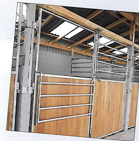
Den nedfældelige klap i skydelågen fremmer både kontakten mellem hest og menneske og mellem hestene indbyrdes.
