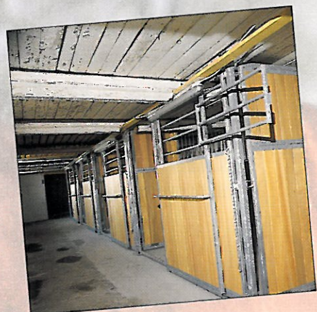
De massive, ovntørrede planker gør boksene langtidsholdbare, og hestene kan ikke træde igennem dem.
