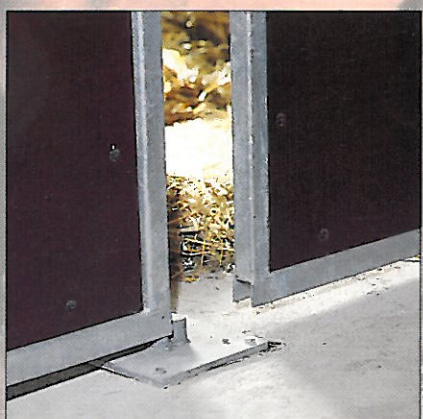
Styretappé gør det nemt at åbne skydelågerne. Samtidig undgår man at få en bundskinne, der samler gødning og er generende for hesten.
