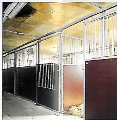
Bokse med skydelåger er forsynet med dobbelte rullelejer, så de hurtigt kan åbnes i enhver situation - også indefra.
